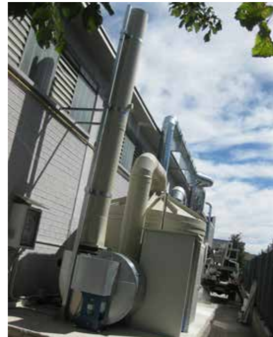
Applicazione Barriera Osmogenica ad ultrasuoni come stadio aggiuntivo di abbattimento
